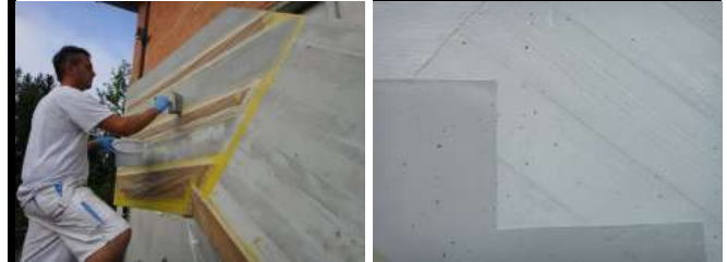
Brettschalungen mit Schalungsstössen
