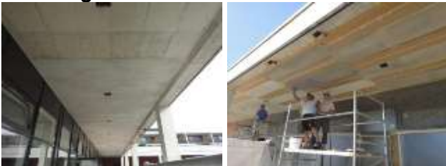
Schalung im Deckenbereich strukturieren
