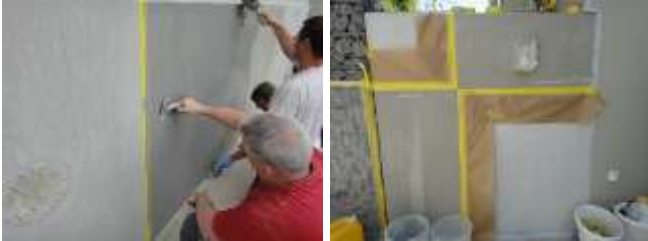
Schalungstafeln im Mauerbereich
